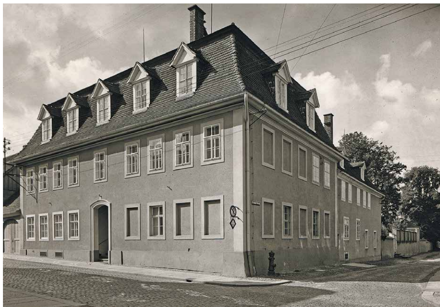
Das „Direktorenhaus“, in dem von 1933–1945 das Firmenarchiv und -museum untergebracht waren.
